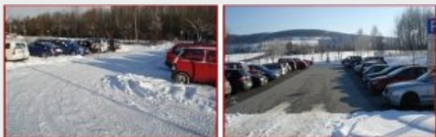
Parkoviště s vrstvou uježděného sněhu a parkoviště, pod kterým je instalován tepelný kolektor.
